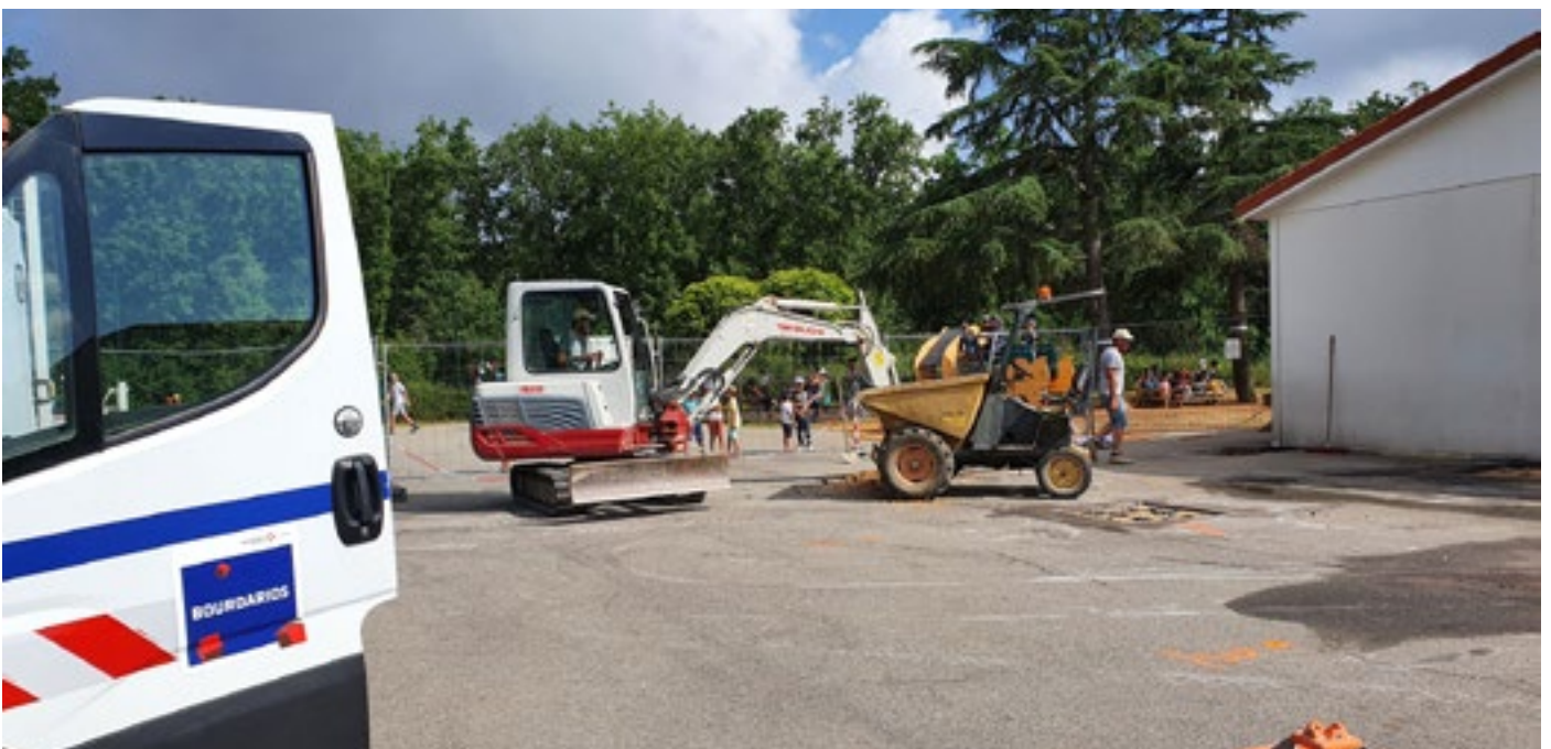
Le chantier de l'école a débuté.
